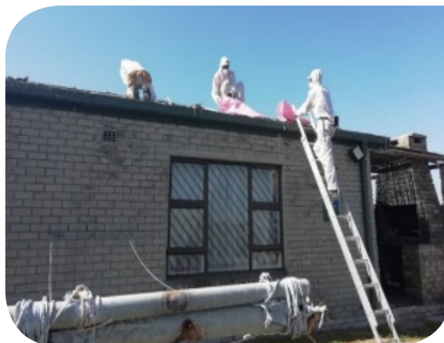
lingcali ekuqubisaneni ne-asbestos kwiziko lenkcubeko laseMelkbos – ukulungisa uphahla lwendlu karhulumente.
